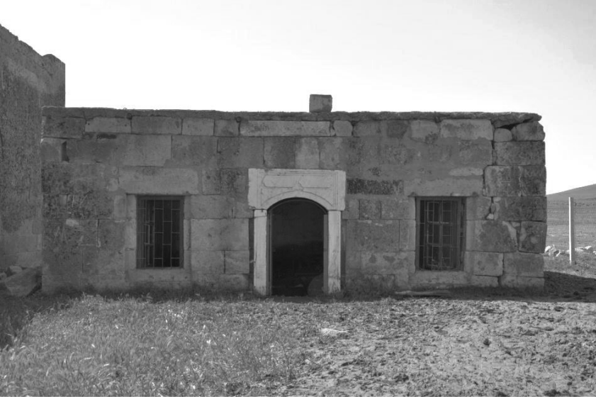
Türbenin giriş cephesi (Haziran 2016)
